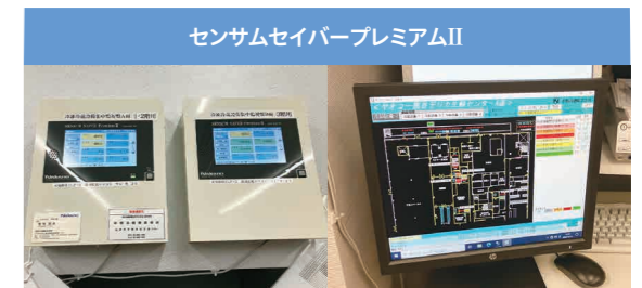
▲冷凍・冷蔵庫の集中監視システム(センサムセイバープレミアムII)
