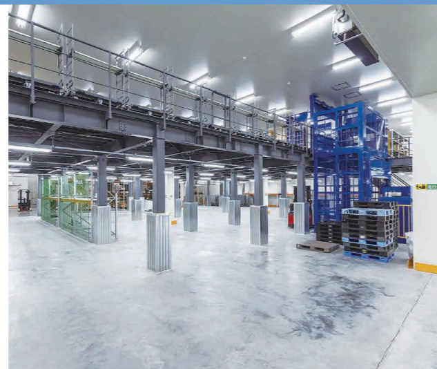
▲冷蔵庫_立体架台下
