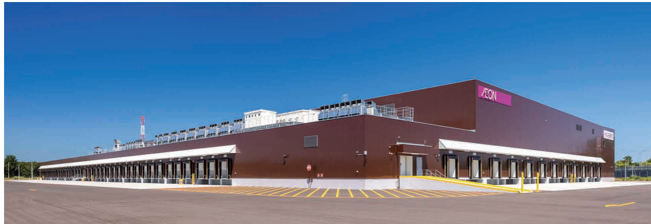
▲「イオン石狩PC」全景 トラックバース合計77台
