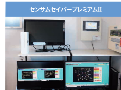
▲冷凍・冷蔵庫の集中監視システム (センサムセイバープレミアムII)
