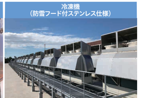
▲屋上に冷凍機を設置
